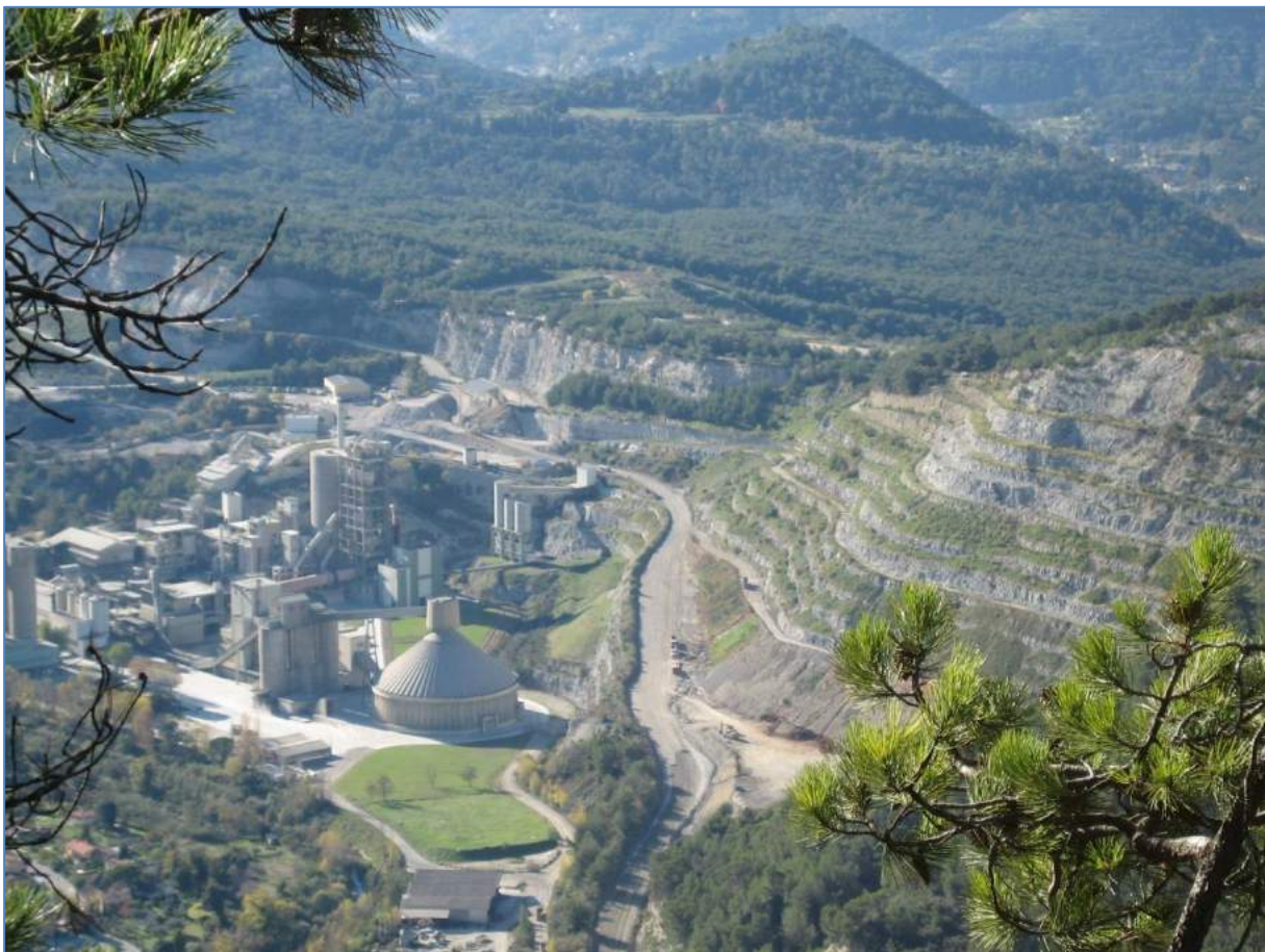
Photo 1 : Usine VICAT de La Grave de Peille
